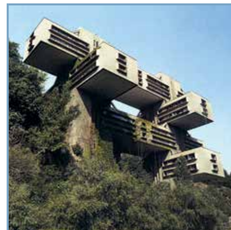
Patrimoine & architecture... , éd. PUR. Ministère géorgien des autoroutes à Tbilissi, Géorgie (1974), G. Tchakhava, Z. Djalaganiya, T. Tkhilava et V. Klinberg arch. Ph. © F. Chaubin.
