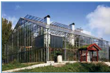
Serre et habitat, éd. Ouest-France. Nature House, maison autoconstruite à Bralanda en Suède (2004). Ph. © Dr.
